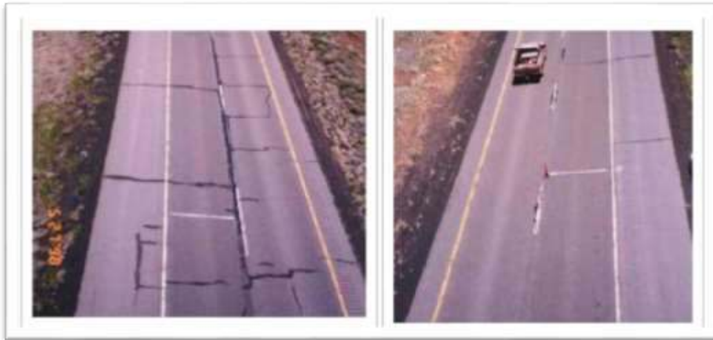
Εικόνα 13 - Αριστερά: δρόμος με συμβατικό ασφαλτόμιγμα, δεξιά: δρόμος με τρίμμα ελαστικού(1990) - Λήψη της φωτογραφίας (1998)
