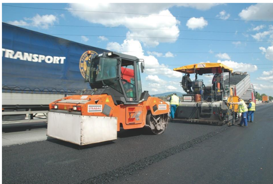
Εικόνα 3: Διάστρωση με διαστρωτήρα (δεξιά) και συμπύκνωση με οδοστρωτήρα διπλού τυμπάνου(αριστερά)[6]
