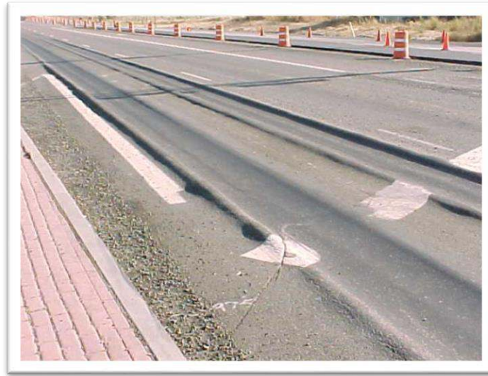
Εικόνα 23 - Τροχοαυλακώσεις επιφάνειας οδοστρώματος
