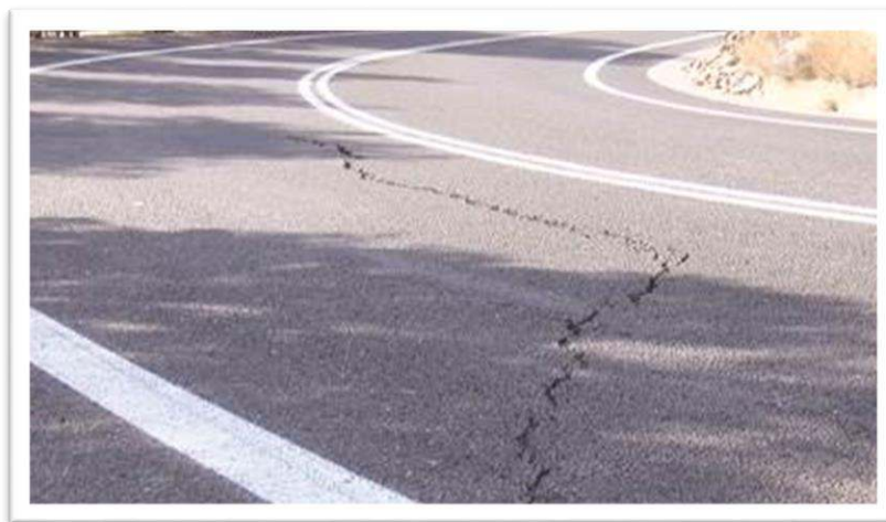
Εικόνα 24 - Ρηγμάτωση οδοστρώματος
