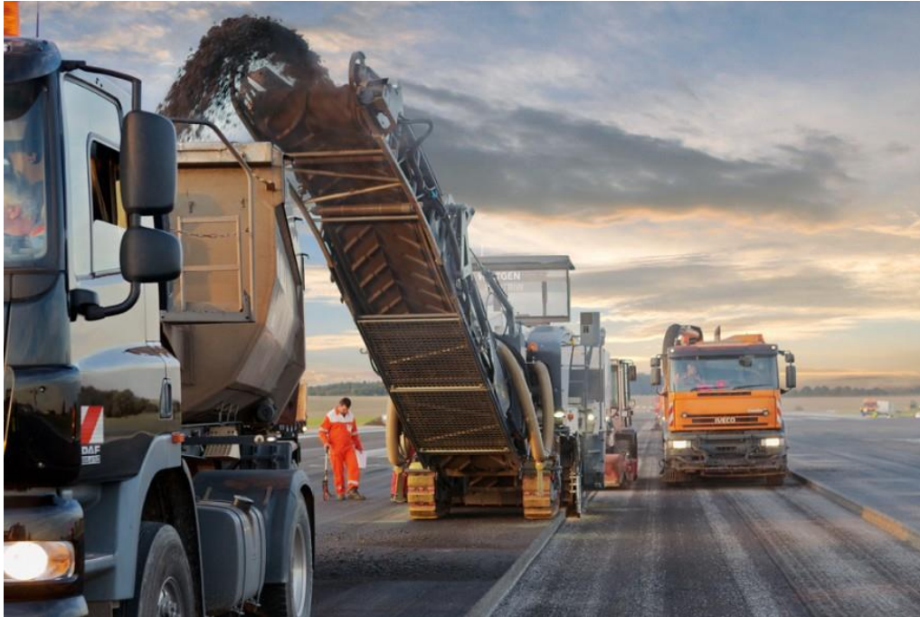
Σχήμα 2. Φρεζάρισμα οδού με εκφόρτωση RAP σε ανατρεπόμενο όχημα και απομάκρυνση των υπολειμμάτων της κοπής με απορροφητικό σάρωθρο [5] .
