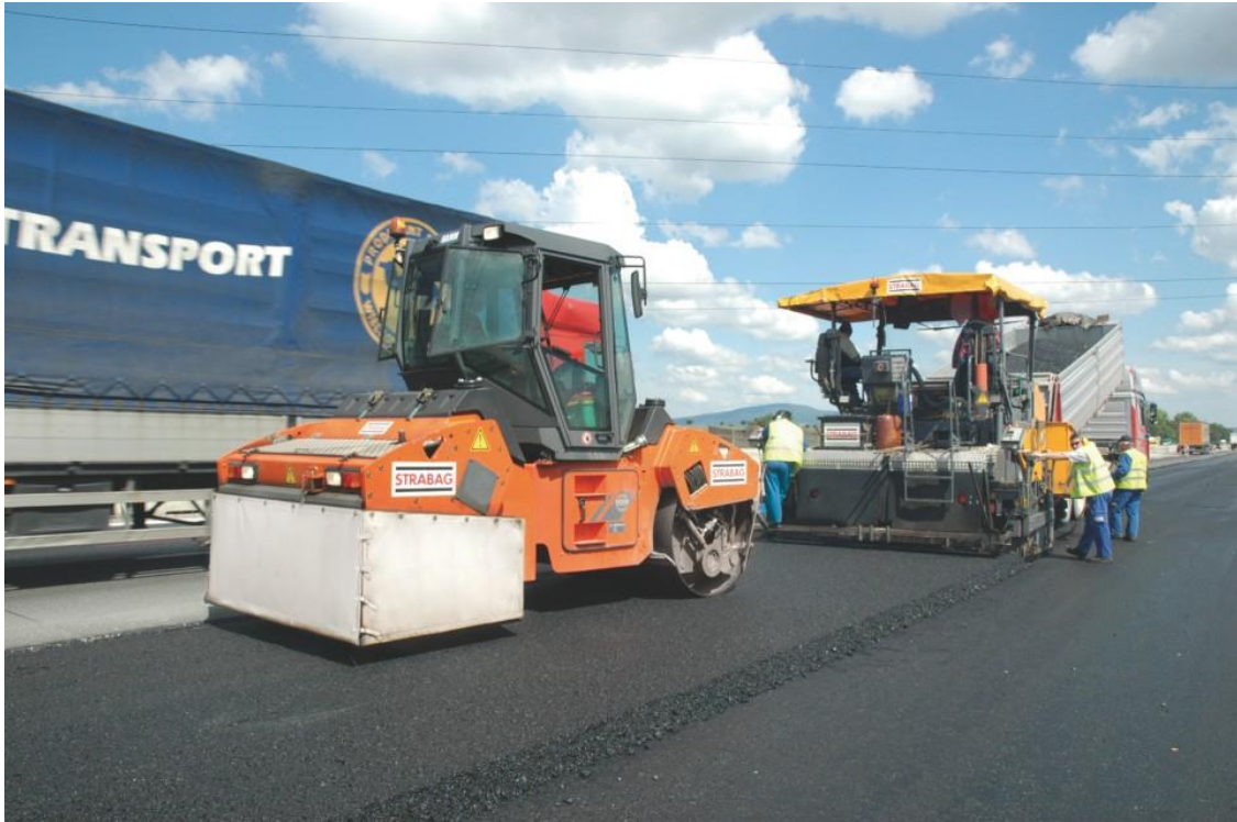
Σχήμα 6. Κυλίνδρωση ασφαλτοτάπητα με οδοστρωτήρα διπλού τυμπάνου [9] .
