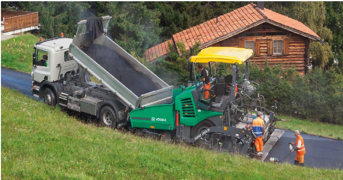
Σχήμα 5. Διάστρωση ασφαλτομίγματος με διαστρωτήρα [8] .
